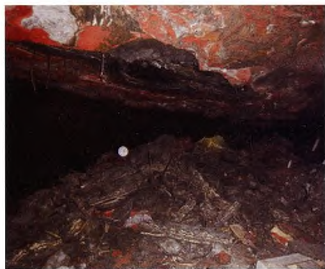
Рис. 1. Пример обрушения кровли выработки на руднике ВКМС
