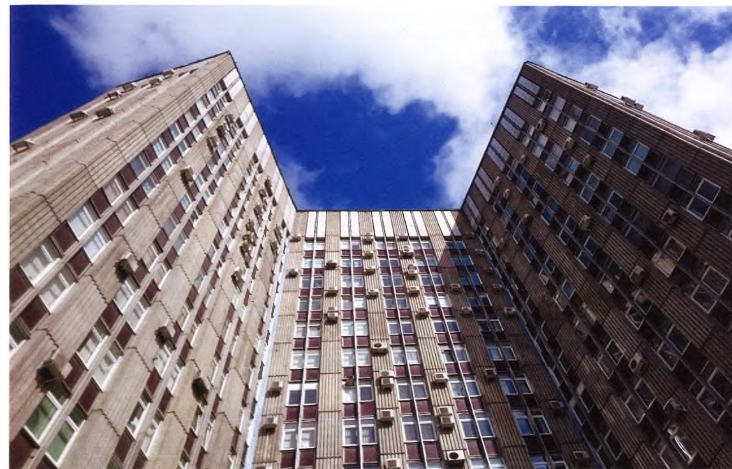
ВНИИ Галургии, г. Санкт-Петербург, проспект Народного ополчения, 2
